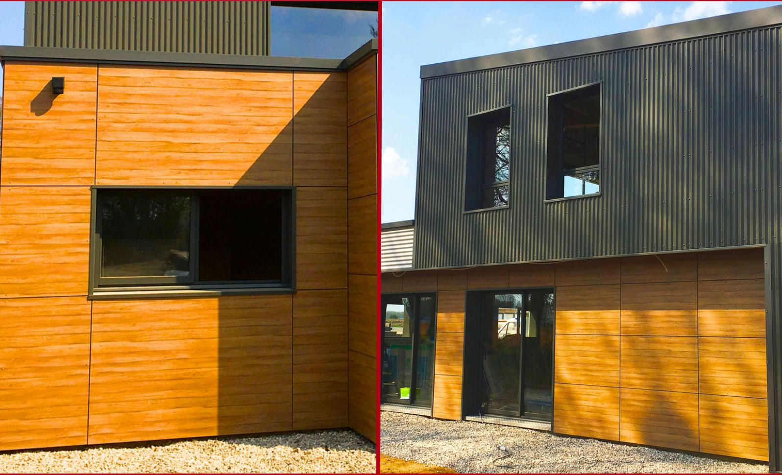
Les panneaux de façade renforcés de fibres de verre sont particulièrement résistants aux rayures et aux chocs, stables à la lumière et faciles à nettoyer.
